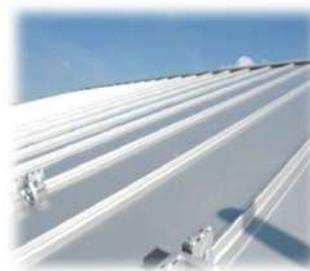
断熱ポリフォーム、制降材、防水性を高めるホットメルト仕様を取り揃えています。最軽量ガルバリウム屋根は、非常に薄い板のため、サイディング材などと比較しても、ガルバリウム鋼板は圧倒的に軽くて丈夫であり耐震性が高いです。長期耐久性を合わせ持つため、特に酸性雨に強く、海岸地域での使用も長寿命化します。
