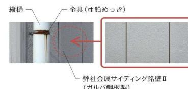
アイジーサイディングは軽量のため、建物の重量も軽くなり、地震時の揺れ幅も小さくなります。また、建物の柱や梁などに躯体にかかる負担を低減できます。さらに独自の工法により、破損・脱落の心配もありません。
